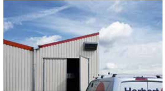
Hallenanbau mit Pultdach
