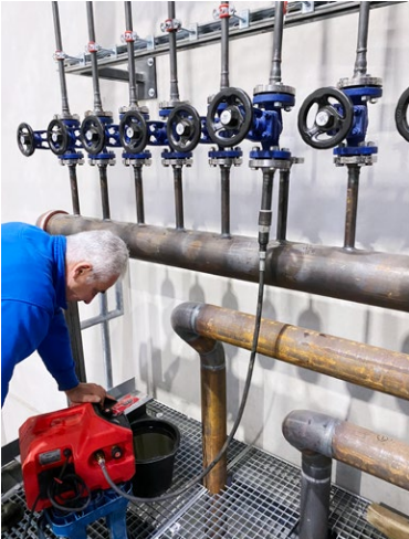
33,7bar: Druckprobe bestanden!
