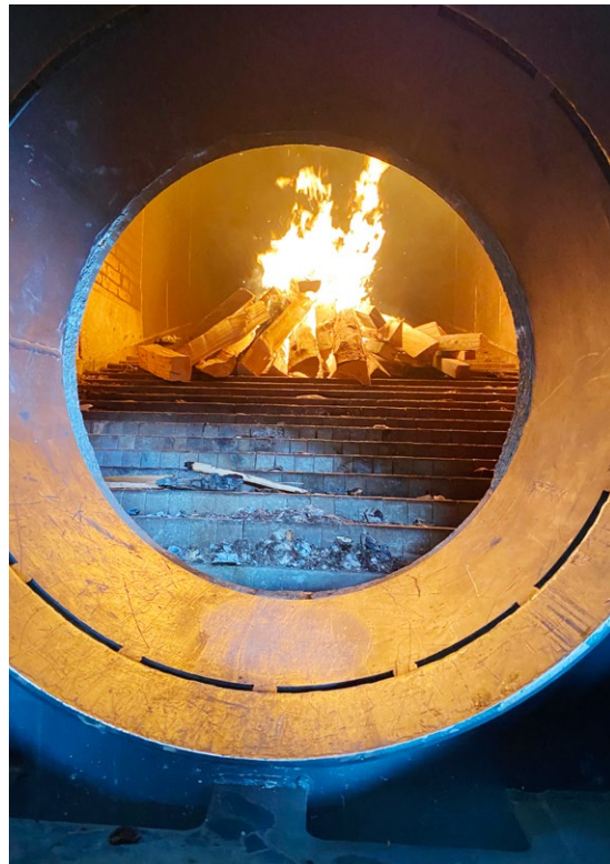
Zum Trocknen der Schamotte-Ausmauerung des Kesselraums wurde mit Scheitholz ein Feuer entfacht. Später wird hier mit Holzhackschnitzeln aus Buchen-Restholz richtig eingheizt.
