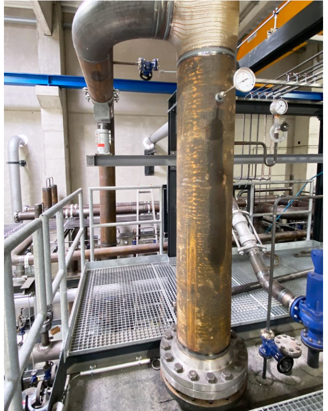
DN350 Kesselanschlussstutzen
