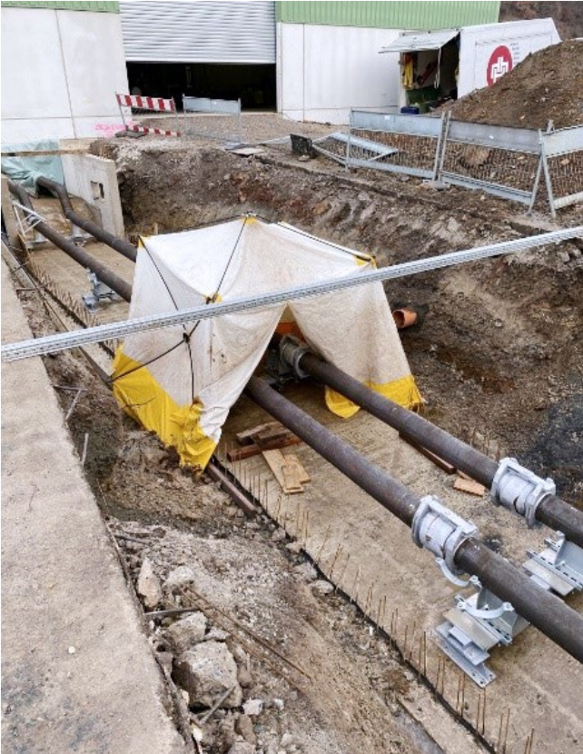
Montage der Fernwärmetrasse im Bodenkanal
