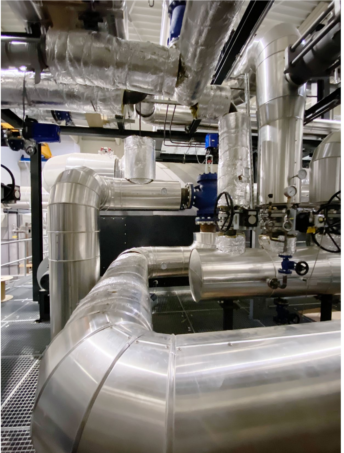
Heißwasserverteiler während den Isolierarbeiten
