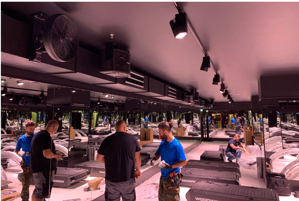
Die Lüftungstechnik im Kursraum nimmt Gestalt an. Techniker von Herbert bei der Arbeit.
